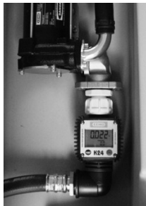
Figure 6.2.2 : Compteur pour cuves 4301 / 4601 / 6001
