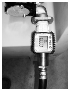
Imagen 6.2.1: Caudalímetro para depósito de 125l / 200l
