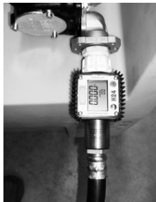
Figure 6.2.1 : Compteur pour cuves 1251 / 2001
