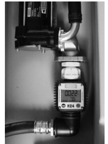
Bild 6.2.2: Durchflusszähler für 4301 / 4601 / 6001-Tank
