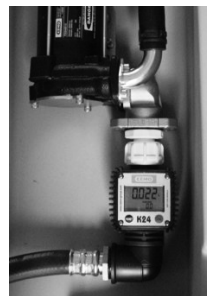
Afbeelding 6.2.2: Debieteller voor 430 l / 460 l / 600 l-tank
